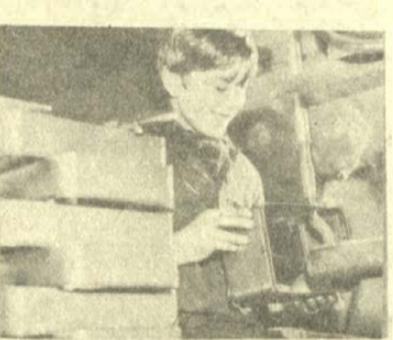
● Nagy Sándor a xenondobozok elemeit erősíti össze ponthegesztővel. (Tóth Sándor felvétele)
