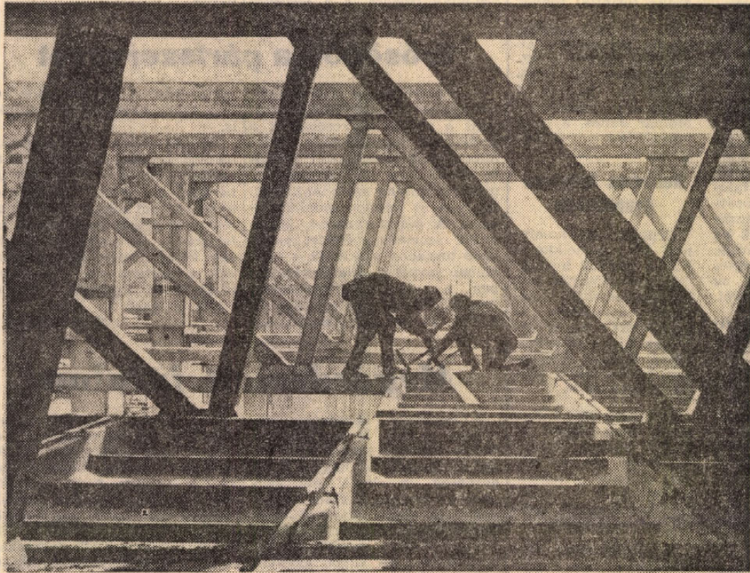
Ácsok dolgoznak a magasban a vasbeton rácsos tartókon.
