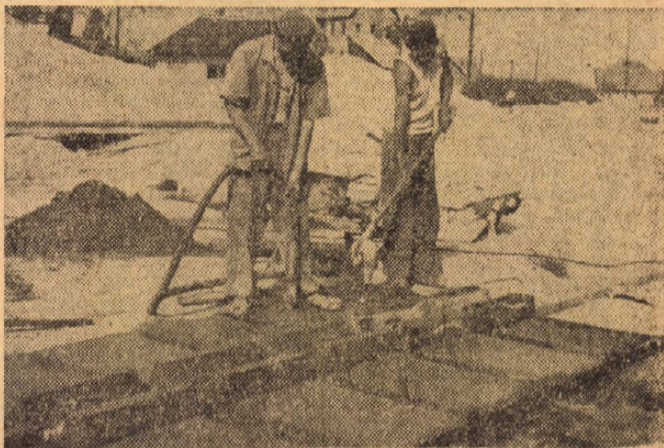
A vibrátor segítségével Horváth József és Dávid Gyula a szocialista címért küzdő Kuti Péter brigádjának tagjai aljzatbetonokat gyártanak, — naponta 35-36-ot.
