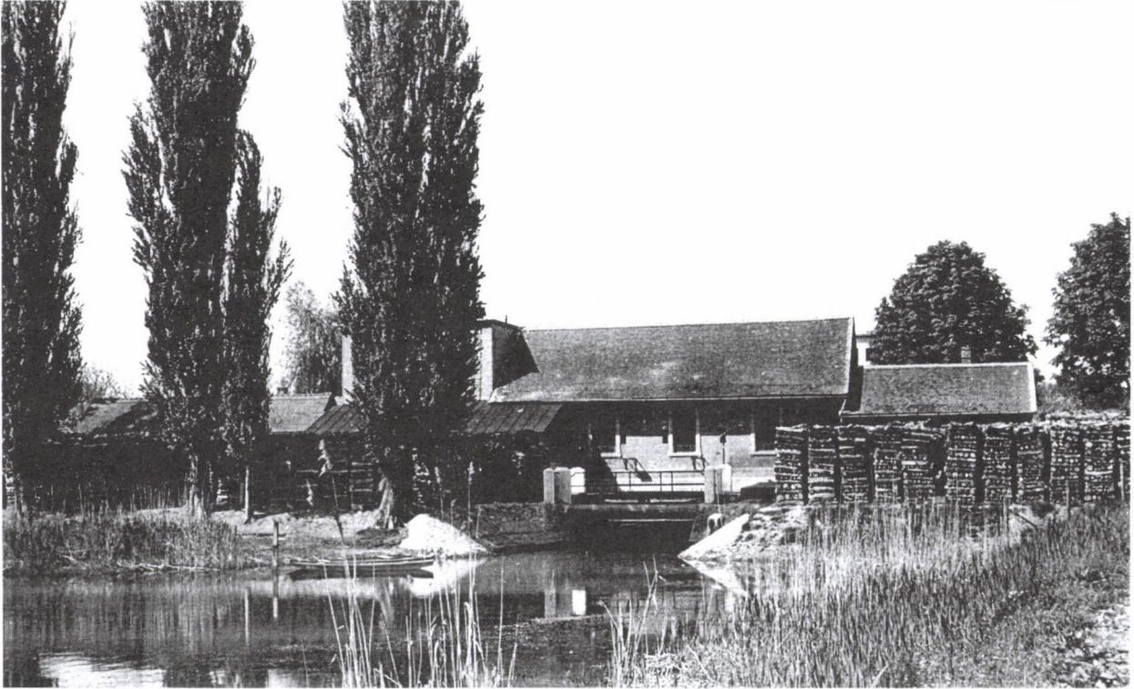
1. kép. A karapancsai szivattyútelep
